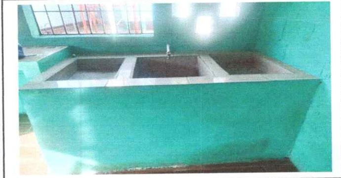
FOTO 19: Sustrucción de pila (incluye base de concreto, instalación hidráulica y sanitaria)
