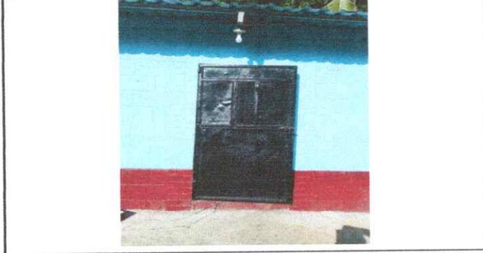
FOTO 22: Mantenimiento de puerta de metal (incluye lijado, cepillado, cambio de tubo y aplicación de pintura anticorrosiva+ esmalte)
