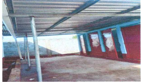
FOTO 2: Sustitución de estructura de soporte de metal (incluye columnas metálicas y base de concret)
