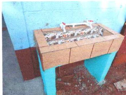
FOTO 12: Suministro e instalación de estación de lavado de concreto y azulejo (incluye sistema hidráulico y sanitario, grifos, tubería y accesorios)
