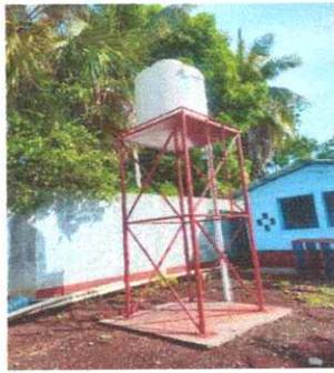
**FOTO 25:** Sustitución de depósito de agua (incluye tubería, accesorios, mantenimiento a estructura portante de metal y bases de concreto)
