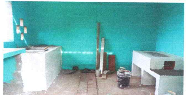
FOTO 24: Resane y aplicación de pintura latex acrilica en muros exteriores e interiores
