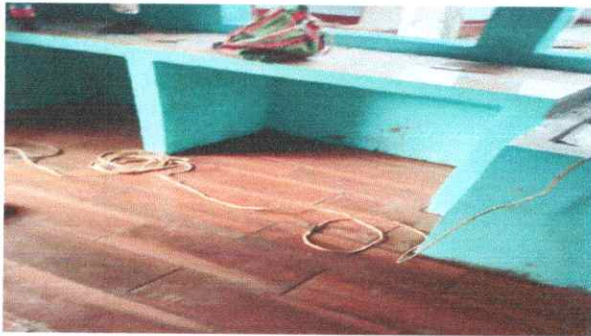
FOTO 17: Suministro e instalación de piso antideslizante
