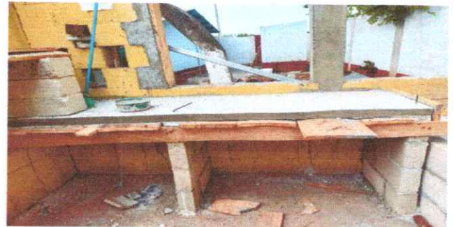
FOTO 18: Suministro e instalación de banco de trabajo de concreto y azulejo
