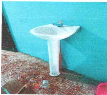
FOTO 9: Reparación de lavamanos
