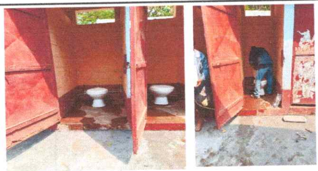
FOTO 5: Reparación de inodoro
