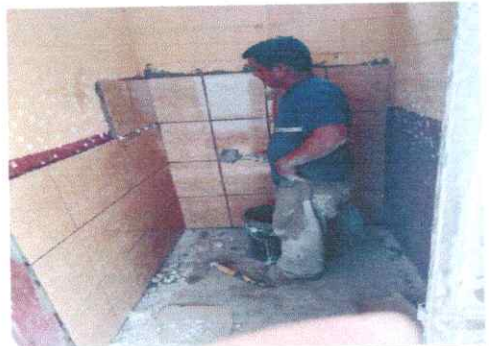
FOTO 6: Suministro e instalación de azulejo
