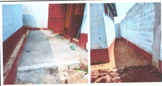
FOTO 4: Reparación de pavimento de concreto (incluye banqueta)
