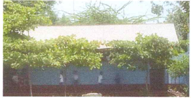
FOTO 26: Resane y aplicación de pintura anticorrosiva en lámina existente de módulos de aulas
