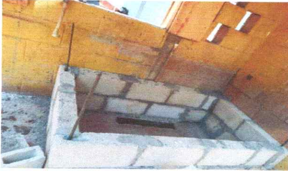
FOTO 19: Sustrucción de pila (incluye base de concreto, instalación hidráulica y sanitaria)
