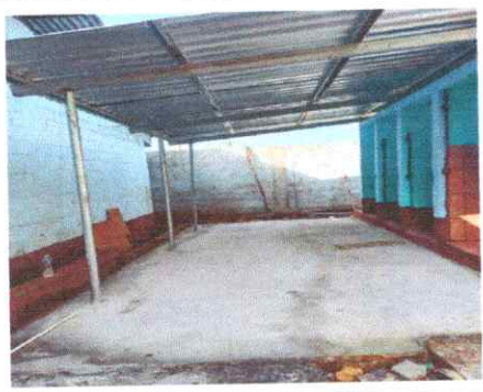
FOTO 3: Suministro e intalación de canal de metal (incluye bajada de agua)
