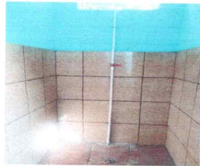
FOTO 10: Reparación de ducha
