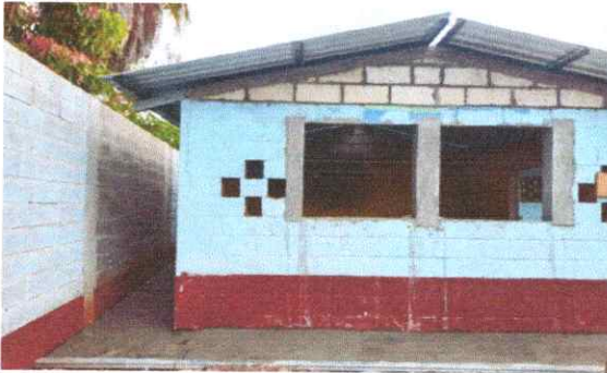
FOTO 15: Conformación de banqueta
