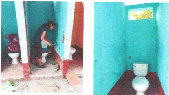
FOTO 11: Resane y aplicación de pintura latex acrílica en muros exteriores e interiores
