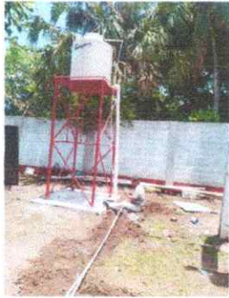
FOTO 25: Sustrucción de depósito de agua (Incluye tubería, accesorios, mantenimiento a estructura portante de metal y bases de concreto)
