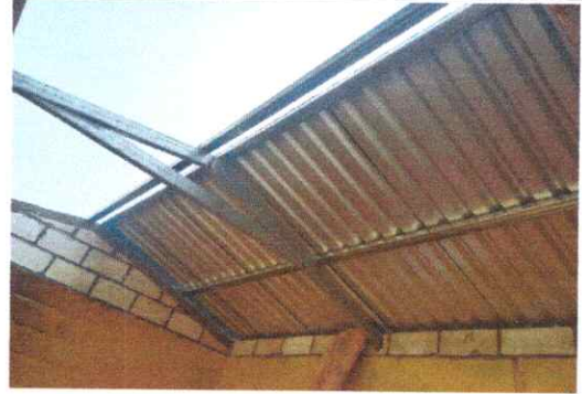
FOTO 14: Sustrucción de estructura de soporte de metal (incluye conformación de muro + mojinete)
