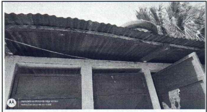
Foto 2: Sustrucción de estructura de soporte de metal (incluye columnas metálicas y bases de concreto)
