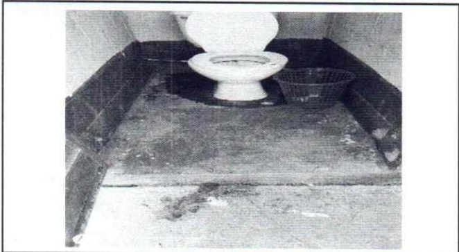
Foto 7: Suministro e instalación de piso cerámico antidelzante
