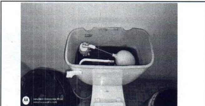
Foto 5: Reparación de inodoro
