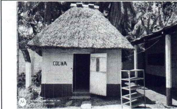
Foto 13: Sustitución de lámina por lámina troquelada calibre 26 ( incluye tornillos, montaje y desmontaje)
