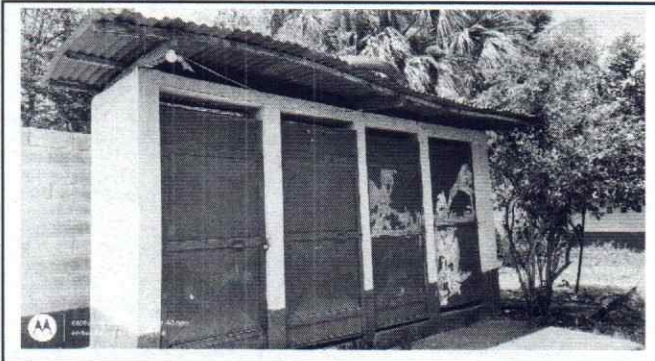
Foto 3: Suministro e instalación de canal de metal (incluye bajadas de agua)
