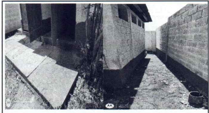
Foto 4: Reparación de pavimento de concreto (incluye banqueta)
