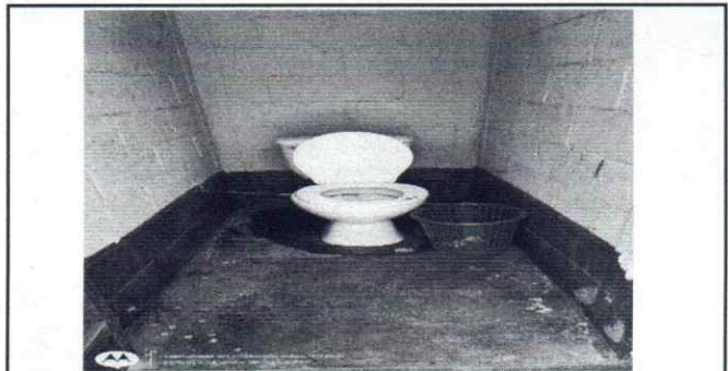
Foto 6: Suministro e instalación de azulejo
