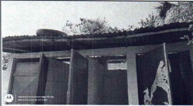
Foto 1: Sustrucción de lámina por lámina troquelada calibre 26 (incluye tornillos, montaje y desmontaje)
