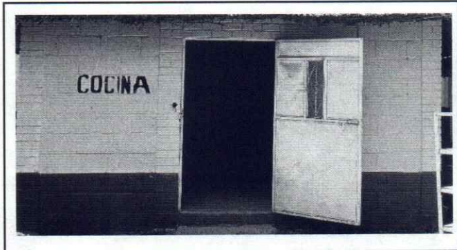
Foto 22: Mantenimiento a puerta de metal (incluye lijado, cepillado, cambio de tubo y aplicación de pintura anticorrosiva + esmalte)
