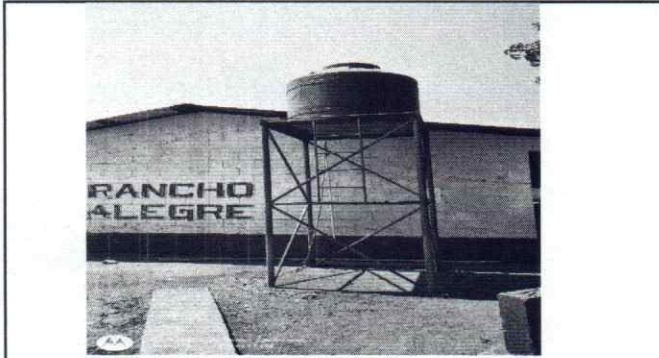
Foto 25: Sustrucción de depósito de agua ( incluye tubería, accesorios, mantenimiento a estructura portante de metal y bases de concreto
