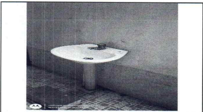
Foto 9: Reparación de lavamanos
