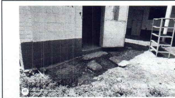
Foto 15: Conformación de banqueta
