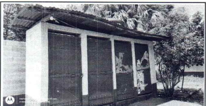
Foto 11: Resane y aplicación de pintura latex acrílica en muros exteriores e interiores
