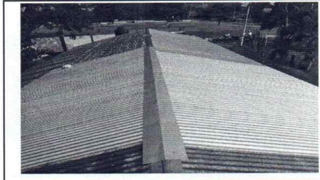
Foto 26: Resane y aplicación de pintura anticorrosiva en lámina existente de módulos de aulas
