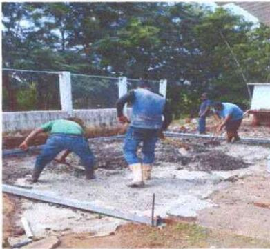
Foto 3: Se observa trabajo de torta de concreto
