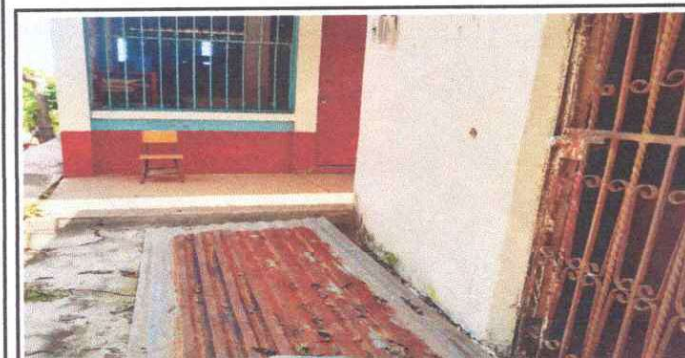
Foto 5: Se observa el área donde pasara la tubería principal
