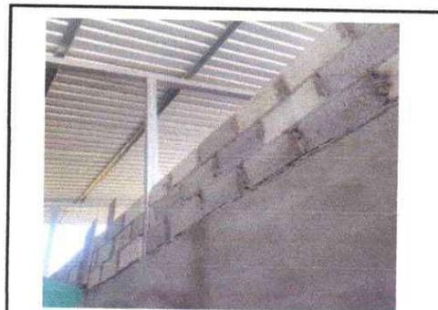
Foto 8: se observa el proceso de los tres hiladas de blok de la pared en el servicios sanitarios
