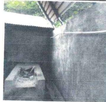
Foto 6: Sustitución de estufa Rural e incluye chimenea tipo campana.
