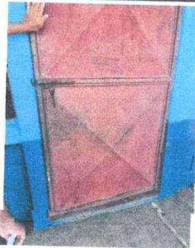
Foto 3: Se ve la necesidad de sustituir el pasador por instalación de chapa para mas seguridad.
