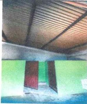
Foto 9: Se ve la necesidad de sustituir las láminas porque ya existe filtración de agua en servicio sanitario.
