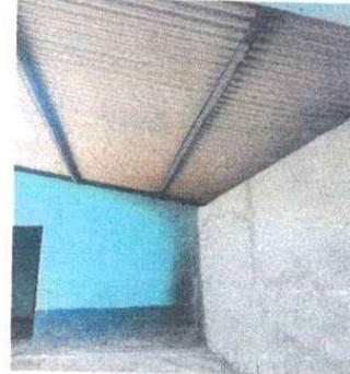
Foto 8: Se ve la necesidad de levantar tres hiladas de block de la pared en servicios sanitarios.
