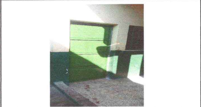
Foto 3: Se observa ya instalada la puerta nueva de metal
