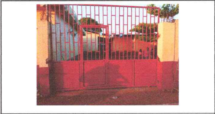
Foto 5: Se observa que el portón ya fue cambiado e instalado
