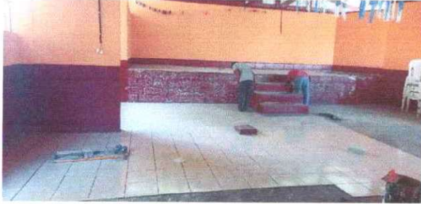
Foto 7: Se observa que se esta aplicando en la base de cemento el piso cerámico
