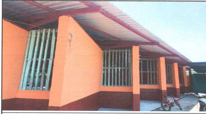
FOTO 1: Se observa la finalizacion de cambio de lamina.
