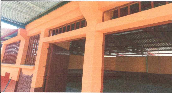
FOTO 3: Se observa la finalizacion de pintado.
