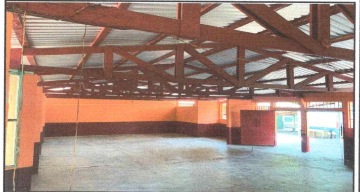
FOTO 2: Se observa la finalizacion de cambio de estructura de madera.
