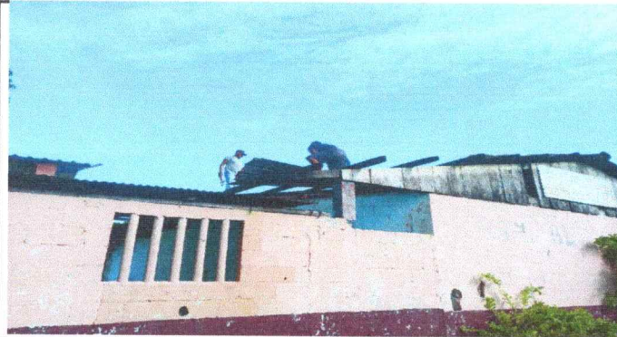
FOTO 1: Se observa el proceso de cambio de lamina que esta deteriorada
