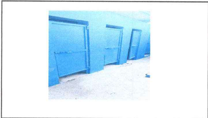
Foto 9: Se arreglaron puertas de sanitarios
