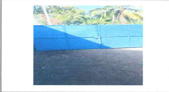
Foto 13: Se reparó portón
