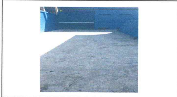
Foto 7: Se arregló el acceso a los sanitarios
