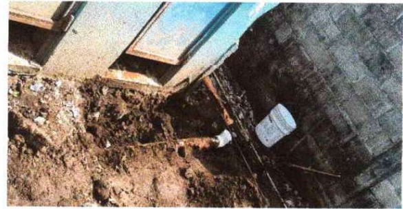
Foto 10: Se observa el cambio de la tubería principal
