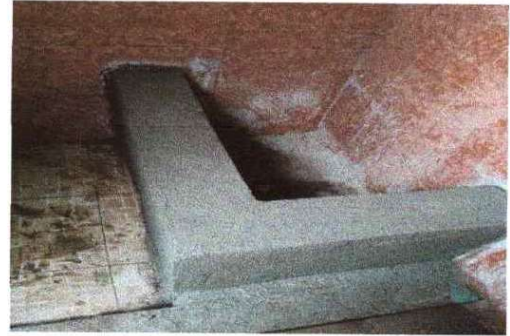
Foto 8 Se observa el proceso de reparacion del migitorio
