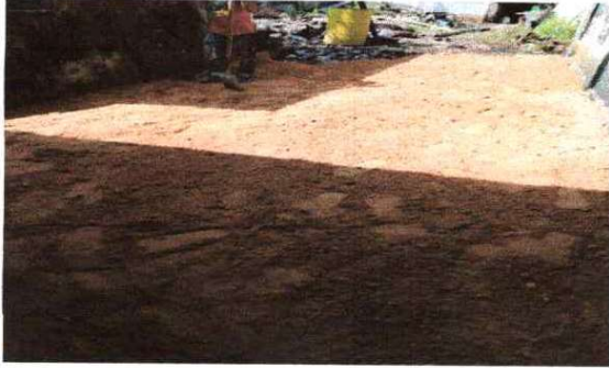
Foto 7: Se observa la reparacion de torta de cemento acceso a los servicios sanitarios
