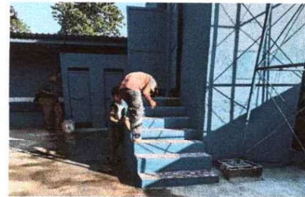
Foto 12: Se observa la reparacion de las gradas
