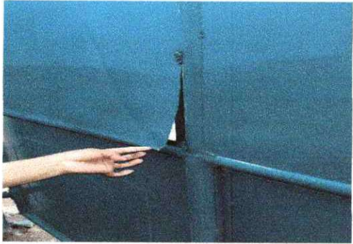
Foto 13: Se observa el mantenimiento a porton se agrego lamina en la parte de arriba
