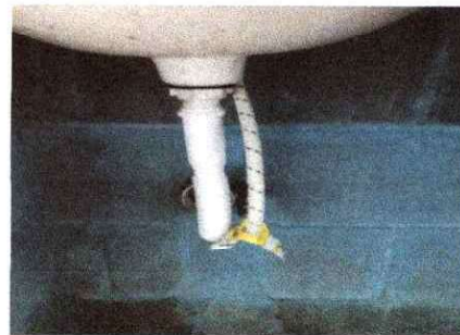
Foto 6: Se observa el camnio de accesorios a lavamanos
