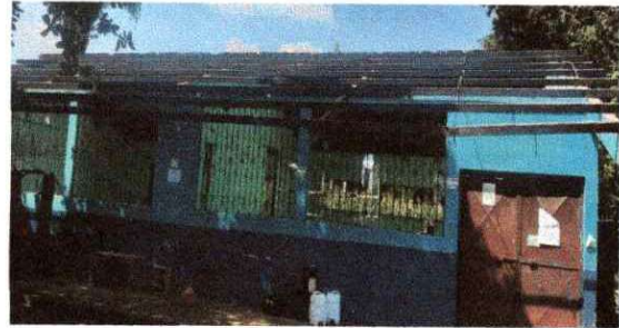
Foto 2: Se observa el mantenimiento de la estructura
