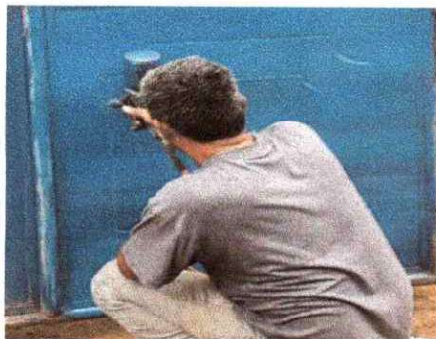
Foto 3: Se observa el mantenimiento a puerta de aula
