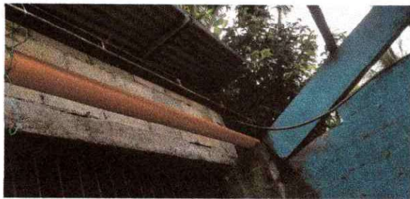
Foto 5: Se oobserva el proceso de sustitucion de canal de pvc
