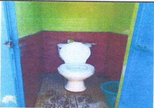
Foto 11: Mantenimiento de servicios sanitario y accesorios
