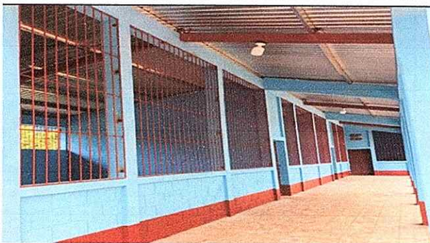
FOTO 4: Instalación de balcones nuevos
