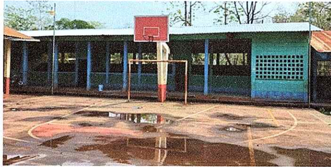
FOTO 1: Finalización de mantenimiento a estructura portante de metal e instalación de lámina troquelada calibre 26
