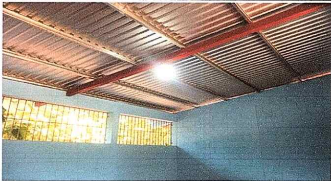
FOTO 5: Sistema eléctrico instalado.
