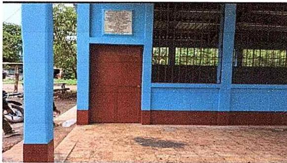
FOTO 3: Mantenimiento a puertas de metal concluido.
