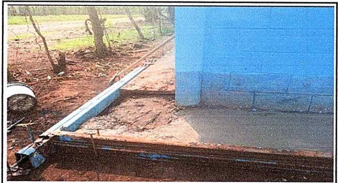
Foto 2: Se está reparando la banqueta.
