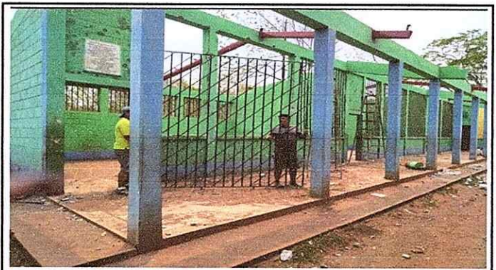
Foto 4: Quitando balcones para ser sustituidos por nuevos.
