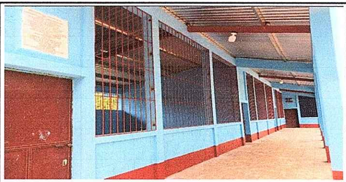
Foto 5: Realizando instalación Eléctrica.
