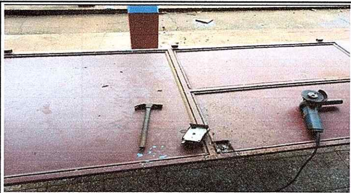
Foto 3: Dando mantenimiento a puertas, se procede a lijar, pintar e instalar chapas
