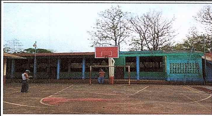
Foto 1: Se evidencia que se ha iniciado con la sustitución de techo.
