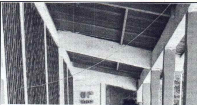
Foto 5: Sustrucción de sistema eléctrico ( incluye 25 luminarias, 13 tomacorrientes, 7 apagadores, 1 tablero + flipones, cableado y accesorios
