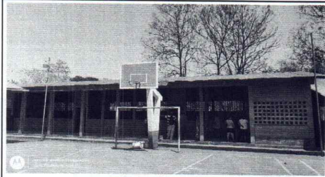
Foto 1: Sustrucción de lámina troquelada calibre 26 (incluye montaje y desmontaje), mantenimiento a estructura portante de metal (incluye, fijado, cepillado, cambio de piezas dañadas y aplicación de pintura anticorrosiva
