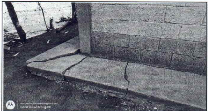
Foto 2: Reparación de banqueta
