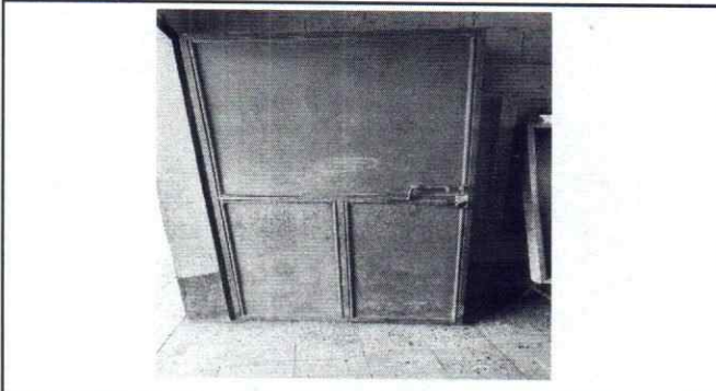
Foto 3: Mantenimiento a puertas de metal ( incluye, lijado, cepillado, cambio de tubo, cambio de chapas y aplicación de pintura anticorrosiva mas esmalte
