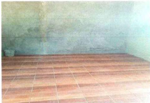
Foto 3: Se observa finalizado la colocación de piso cerámico en la aulas
