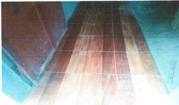
Foto 3: Se observa que se está colocado piso cerámico en la aulas.
