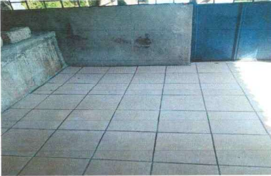
Foto 7: Se observa que el piso de la cocina le están colocando piso cerámico
