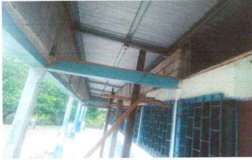
Foto 1: Se observa que se le está dando mantenimiento a los balcones.
