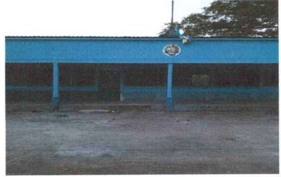
Foto 8: Se observa que se le esta colocando el resane y pintura a las paredes exteriores
