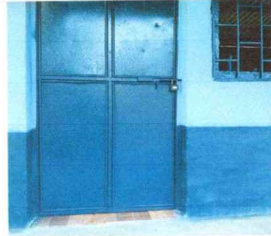
Foto 2: Se observa que se le está dando mantenimiento a la puerta.
