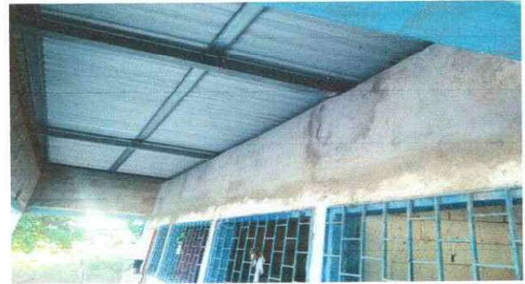
Foto 4: Se observa el cierre de las 4 hiladas de block
