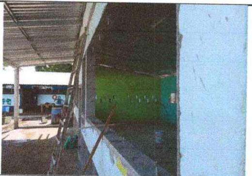
Foto 5: Se observa que los balcones fueron removidos para poder sustituirlos.
