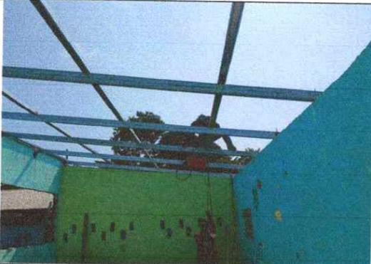
Foto 3: Se observa que la estructura de soporte de madera está siendo sustituida.
