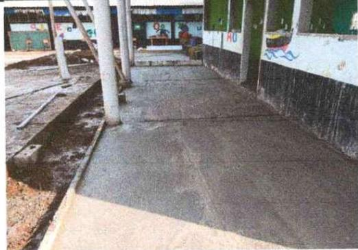
Foto 8: Se observa la falta de torta de concreto en area exterior del modulo I, se está sustituyendo.
