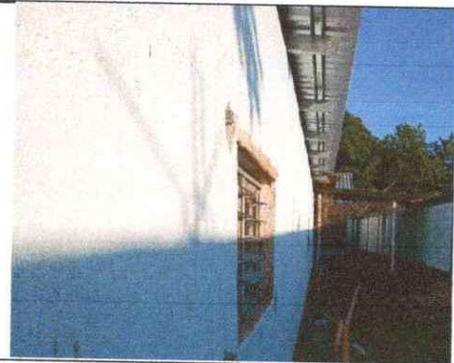
Foto 6: Se observa que en el aula del módulo 1, las ventanas de metal se quitaron para poder sustituir las.
