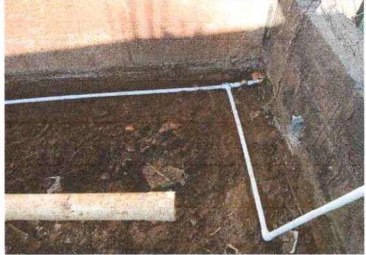
Foto 14: Se observa que la tubería principal, se removió por su mal estado y se colocará una nueva.
