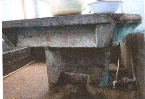
Foto 12: Se observa que es necesario sustituir la pila de cemento de dos lavaderos.
