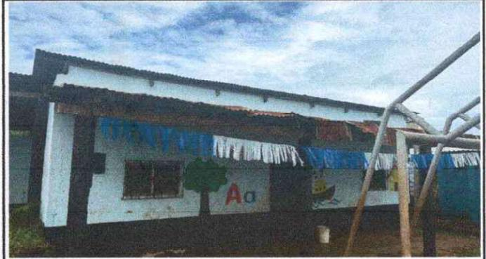
Foto 2: Se observa que las laminas del modulo I se encuentran con mucho óxido y en mal estado es necesario sustituir las.
