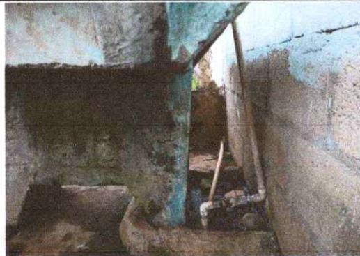
Foto 14: Se observa que la tubería principal, debido al paso de los años se ha deteriorado, la cual es necesario sustituirla.
