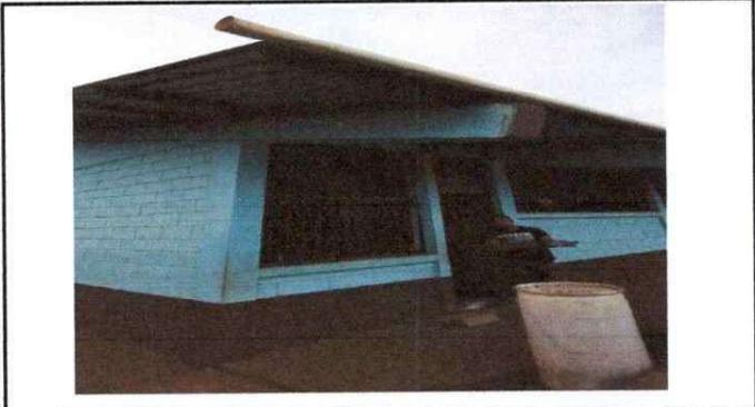
Foto 2: Se observa que es necesario instalar canales pluviales de buena calidad.
