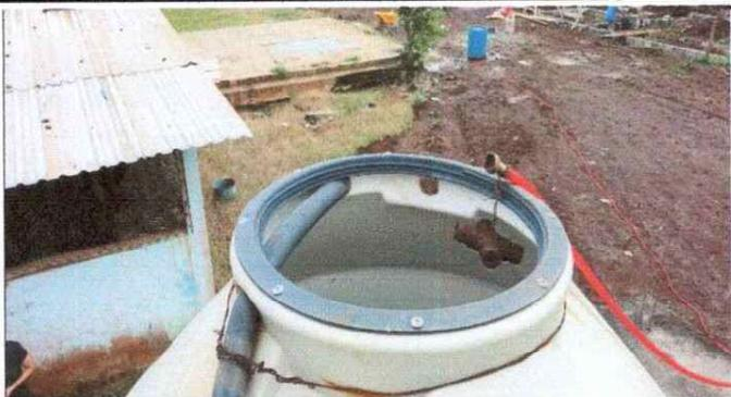
Foto 7: Se observa que el depósito de agua no cuenta con tapadera.
