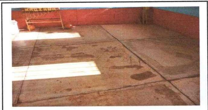
Foto 1: Se observa que el piso necesita ser sustituido por piso cerámico del módulo I Y II
