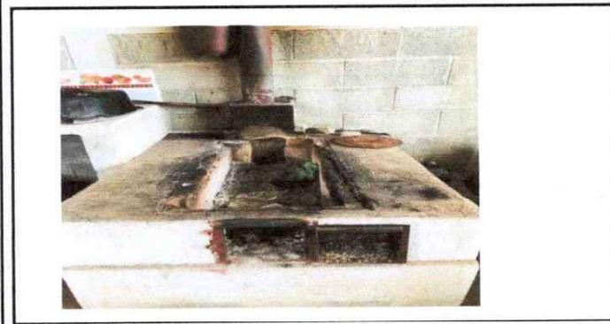
Foto 5: Se observa que la estufa rural tiene múltiples grietas es necesario sustituirla
