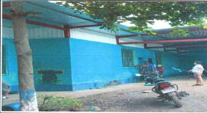
Foto 1: finalizacion del techo del modulo III, IV y V, de lamina troquelada aluzinc calibre 26.
