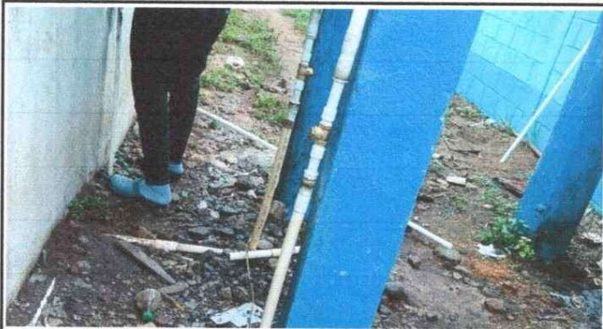
Foto 3: finalizacion de sustitucion de llave de cheque de red de agua potable.
