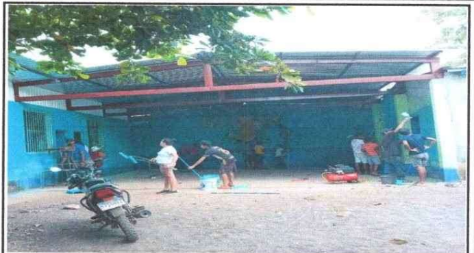
Foto 2: finalizacion de montaje de la estructura de soporte del modulo III, IV y V.
