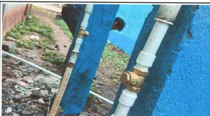
Foto 3: Se observa la sustitucion de llave de cheque de red de agua potable
