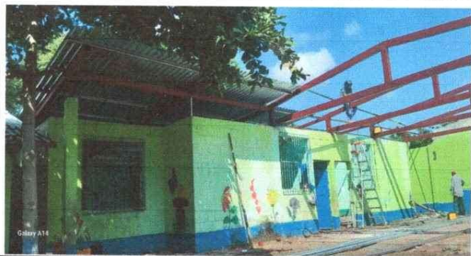
Foto 1: Se observa que el techo del modulo III, IV Y V, se esta realizando el montaje de lamina troquelada aluzinc calibre 26.
