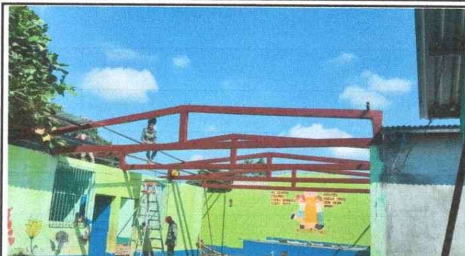
Foto 2: Se observa el montaje de la estructura de soporte del modulo III, IV Y V.
