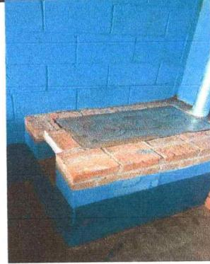
FOTO 2: ESTUFA RURAL REPARADA Y CAMBIO DE PLANCHA DE METAL
