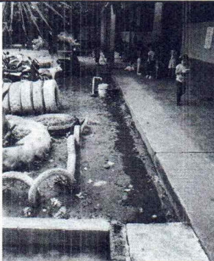
FOTO 9: SE VERIFICO QUE LA TUBERIA DE AGUA DE LA LINEA PRINCIPAL ESTA TAPADA.
