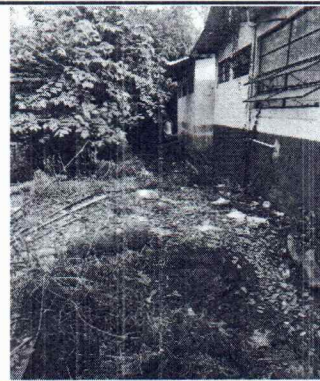
FOTO 10: SE VERIFICO QUE LA FOSA SE LLENO DESDE TIEMPO ATRÁS LA CUAL SE A DEJADO DE UTILIZAR.
