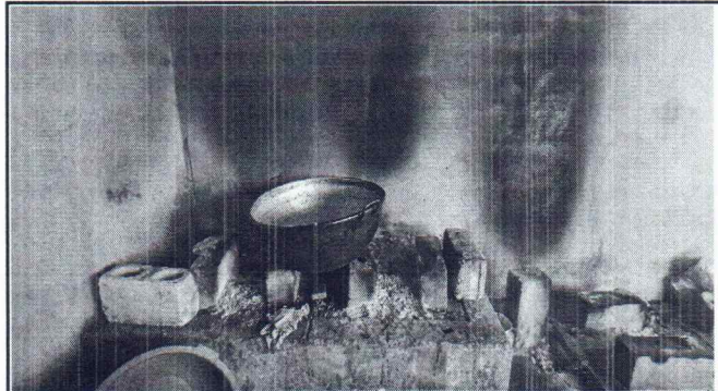
Foto 2: Se observa que se necesita urgentemente sustitución de estufa rural.
