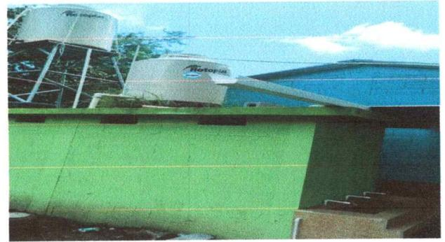
FOTO 14: Finalización de instalación de depósito de agua.
