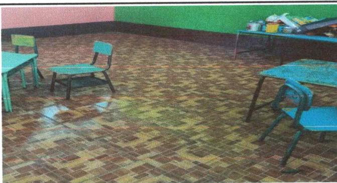
FOTO 17: Finalización de instalación de piso cerámico
