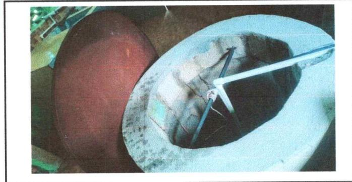
FOTO 6: Proceso de instalación de tapadera de metal en pozo de agua.
