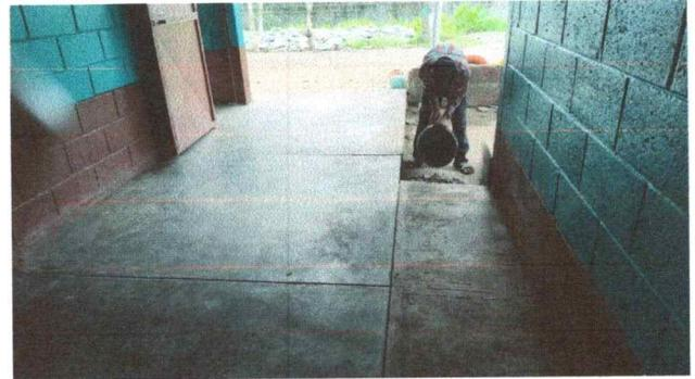
FOTO 16: Proceso de sustitución de piso de torta de concreto.
