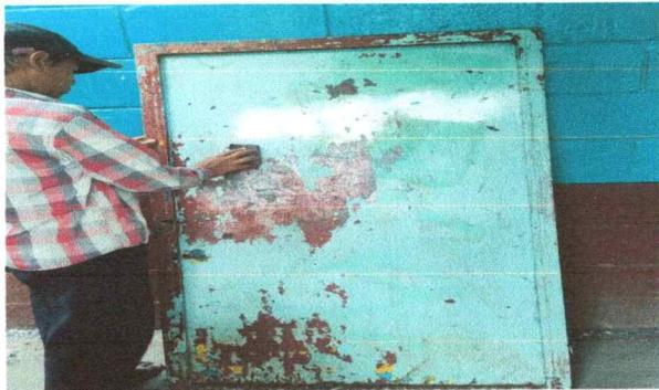
FOTO 11: Proceso de mantenimiento de puerta de metal.
