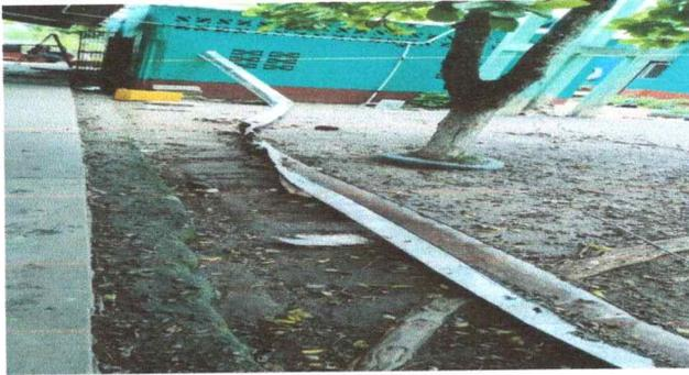
FOTO 15: Proceso de sustitución de canal por PVC.
