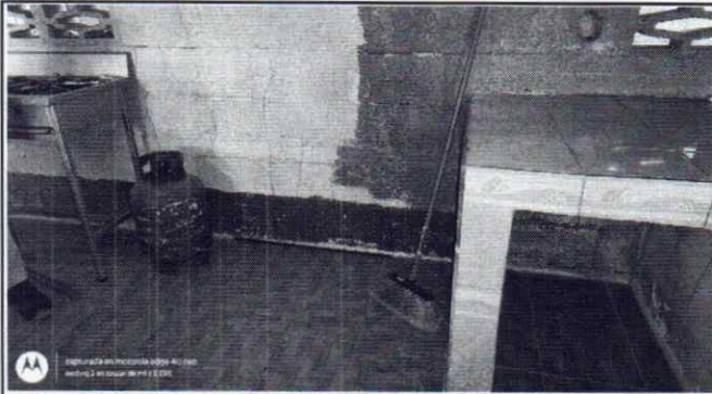
Foto 1: Conformación de bancos de trabajo de concreto y azulejo
