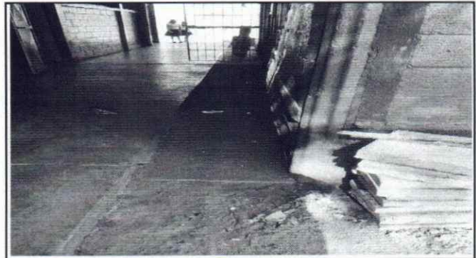
Foto 16: Sustitución de piso de torta de concreto
