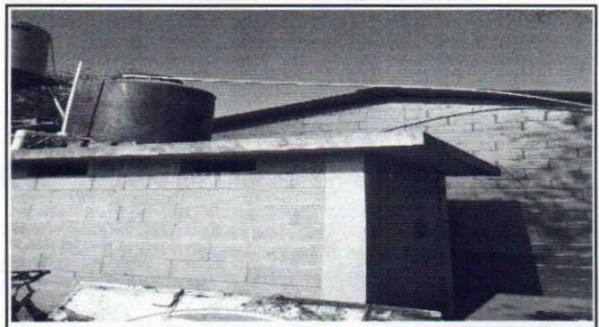
Foto 14: Suministro e instalación de depósito de agua de 1100 litros (incluye accesorios y 20 mts tubería principal)
