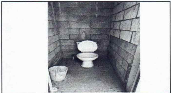
Foto 8: Sustitución de inodoros
