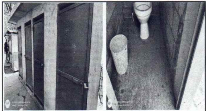
Foto 10: Resane y aplicación de pintura latex acrilica en muros exteriores e interiores suministro e instalación de piso cerámico antidelizante
