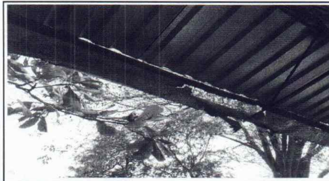
Foto 15: Sustitución de canal de metal por PVC, bajadas de agua pluvial de metal por PVC, soporte de metal para canal
