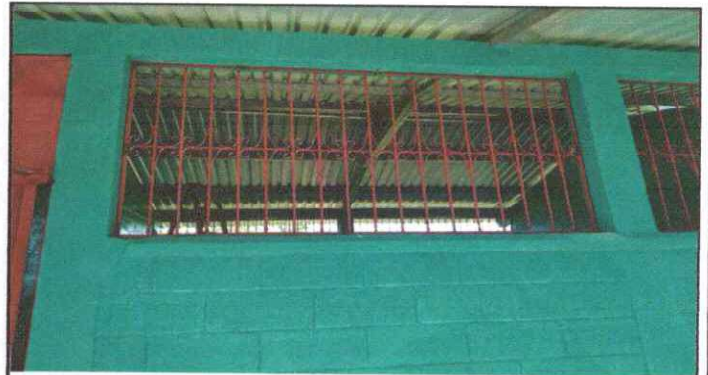
Foto 4: Se colocaron balcones nuevos .
