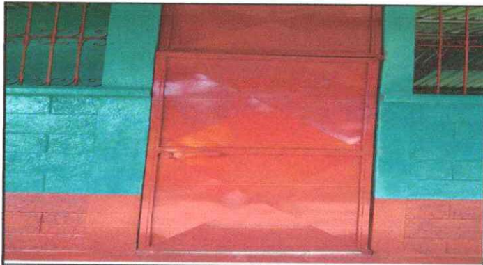
Foto 3: Se observa que las puertas en aulas se sustituyeron .
