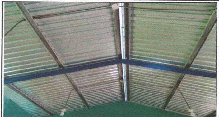
Foto 2: Se observa que la estructura de metal a sido sustituida por nueva.
