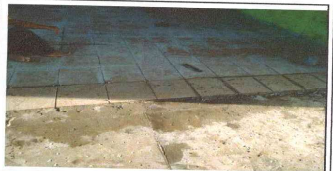
Foto 6: Se observa que se esta colocando piso ceramico.
