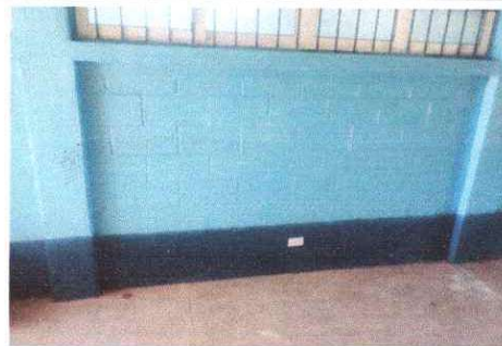
Foto 6: Mantenimiento de paredes interior y exterior de las tres aulas terminado.
