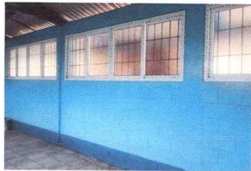
Foto 4: Ventanas ya instaladas en el area pensado.
