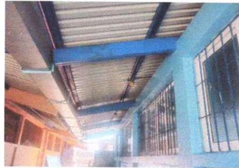
Foto 2: Estructura metalica pintada en las tres aulas.
