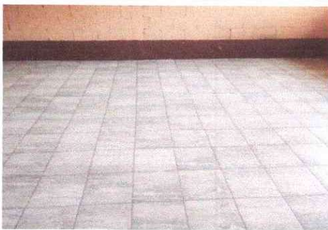
Foto 5: Colocacion de piso terminado.
