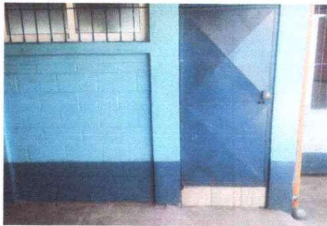
Foto 3: Cambio de chapa de dos puertas y colocacion de chapa en una puerta que no habia.
