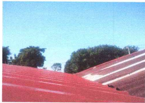
Foto 1: Laminas cambiadas en las tres aulas.
