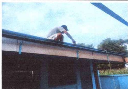
Foto 1: Cambio de lamina en las tres aulas.
