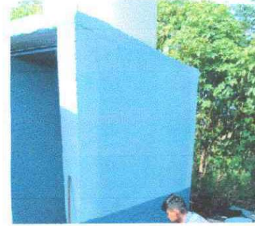
Foto 14: Se observa el proceso del proceso de repello.
