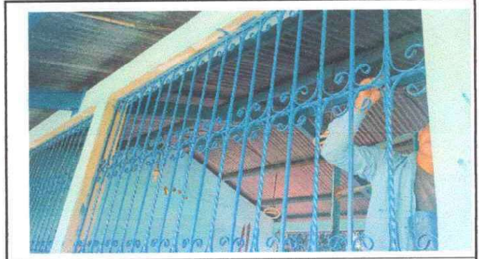
Foto 4: Se observa que se está pintando los balcones de metal
