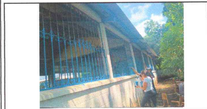
Foto 5: Se observa que se está aplicando pintura.
