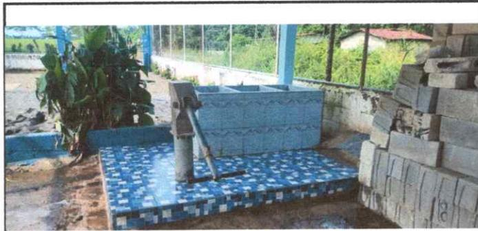
FOTO 5: sustitución de pila, incluye mejora de base, sistema hidráulico y sanitario
