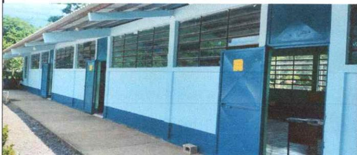
FOTO 2: *aplicación de pintura latex y aceite en muros exterior.*
