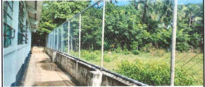
FOTO 4: sustitución de maya metálica en cerca perimetral
