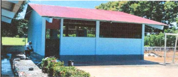
FOTO 1: *Resane pintura anticorrosiva en lamina existente.*
