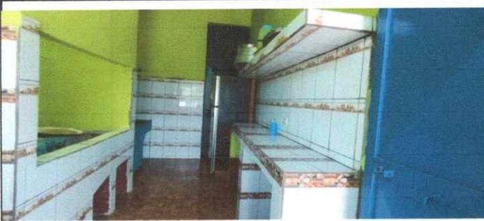
FOTO 1: conformación de banco de trabajo de concreto y azulejo, azulejos en muros.
