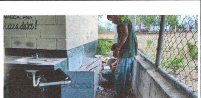
FOTO 4: instalación de mingitorio de concreto y azulejo Incluye sistema hidráulico
