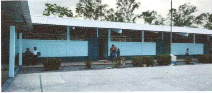
FOTO 1: Resane y aplicación de pintura latex en muros existentes
