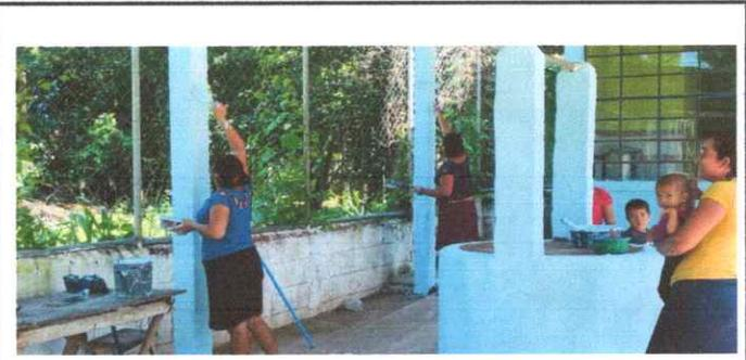
FOTO 6: aplicación de pintura latex en muros existentes.
