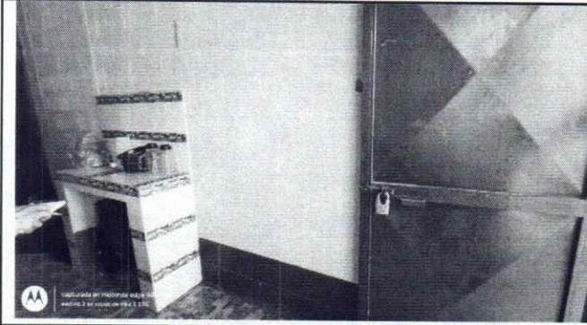
Foto 1: COCINA: Conformación de bancos de trabajo de concreto y azulejo, suministro e instalación de azulejos en muros
