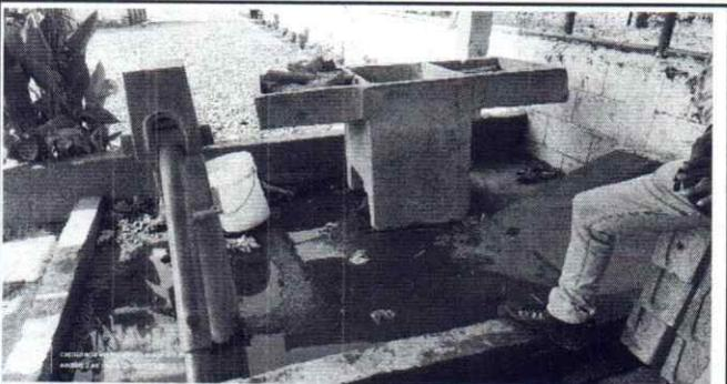
Foto 5: Sustitución de pila ( incluye mejoramiento de base, sistema hidraulico y sanitario )
