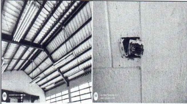
Foto 7: Sustitución de sistema eléctrico ( incluye 27 luminarias, 17 tomacorrientes, 4 flectores, 8 apagadores, cableado y accesorios
