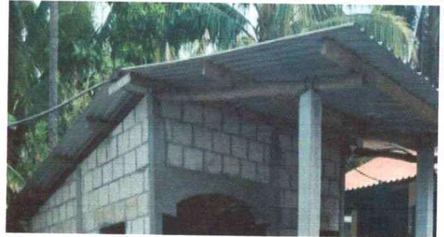
Foto 14: Se observa el mal estado la lámina de la cocina, se necesita mantenimiento.
