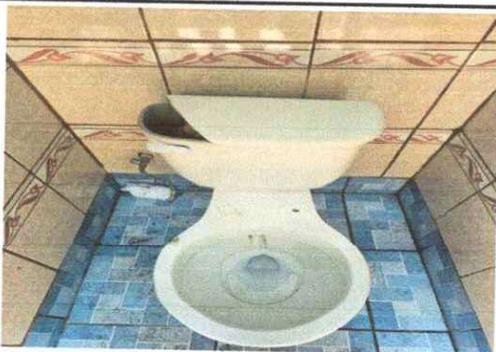
Foto 17: Se observa quebrado la tapadera del deposito de la tasa sanitaria
