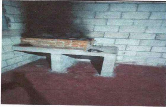
Foto 13: Se necesita colocar una chimenea para evitar el deterioro de la lamina
