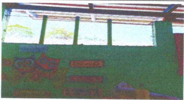
Foto 3: el muro de las aulas no tiene la altura adecuada esta muy bajo y hace mucho calor cuando los niños reciben clases
