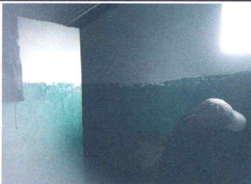
Foto 3: Alisado de muro: se necesita tener un ambiente higienico para cocinar
