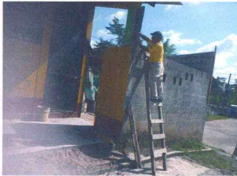
Foto 1: Reparación de muro perimetral de block: Se observa que el muro tiene altura baja
