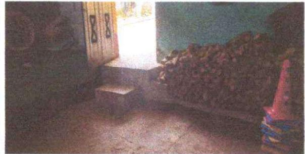
Foto 4: Sustitución de piso torta de concreto se necesita alcanzar una altura adecuada y esta en malas condiciones.
