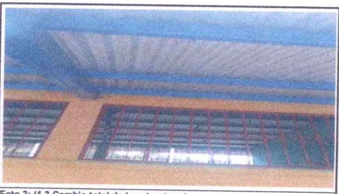
Foto 3: (1.3. Cambio total de la estructura.)
