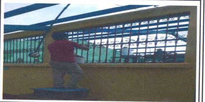
Foto 6: (1.7.Mantenimiento en balcones.)
