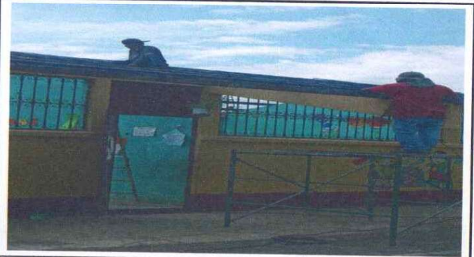
Foto 2: (1.2.Mantenimiento en costaneras.)
