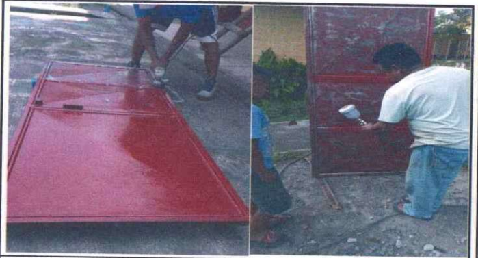
Foto 4: (1.4.Mantenimiento en puertas.)
