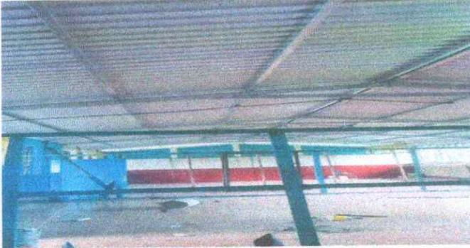
Foto 1: Sustitucion de soporte de madera por metal.
