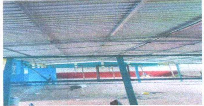
Foto 2: Sustitucion de lamina troquelada aluzinc calibre # 26 ( incluye capote , tornillos, desmontaje y montaje)
