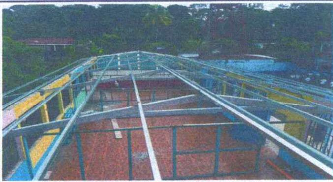
Foto 1: Sustrucción de soporte de madera por metal.
