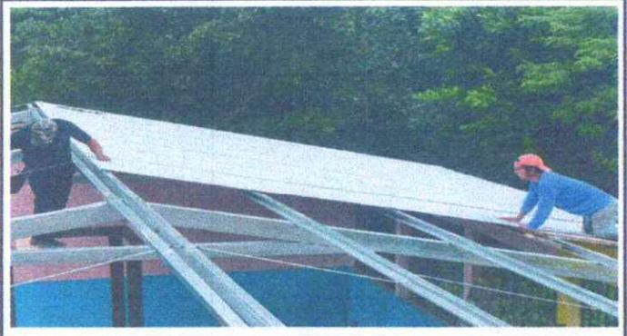
Foto 2: Sustrucción de lamina troquelada aluzinc calibre # 26 ( incluye capote , tornillos, desmontaje y montaje)
