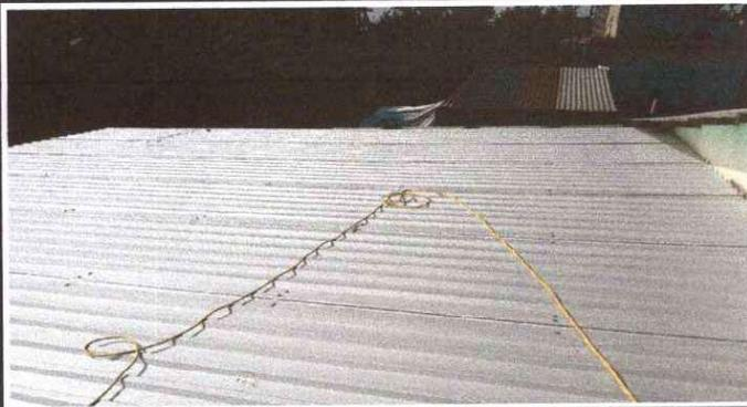
Foto 1: Sustrucción de lamina troquelada calibre 26: Se observa que las laminas estan muy picadas entra demasiada agua.
