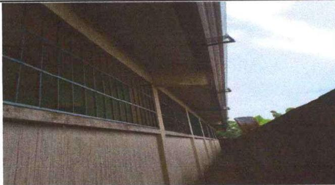
Foto 3: Sustrucción de balcones de metal: Se observa que estan picados por oxido.
