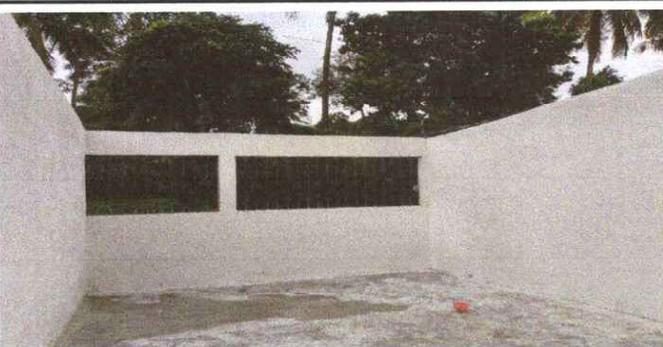
Foto 5: Cernido de muro: Se observa que falta una parte del muro que no esta cernido.
