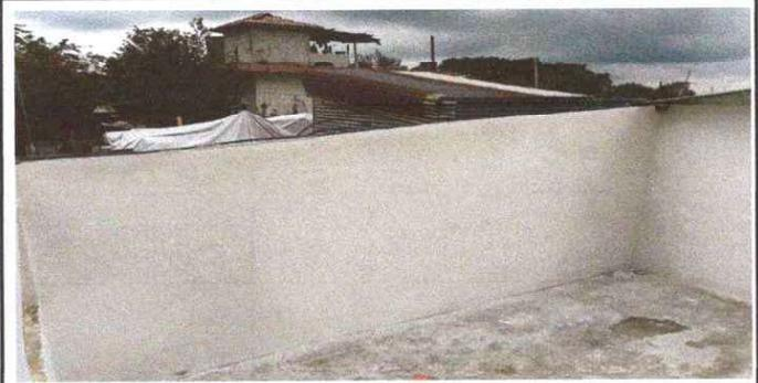
Foto 6: Sustrucción de muro perimetral de block: Se puede observar que el muro tiene grietas y mucha porosidad.
