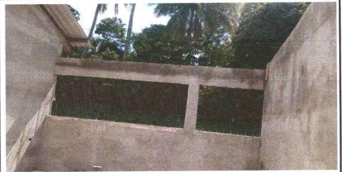
Foto 4: Repello de muro: Se observa que no tiene repello la pred y tiene mucha humedad.
