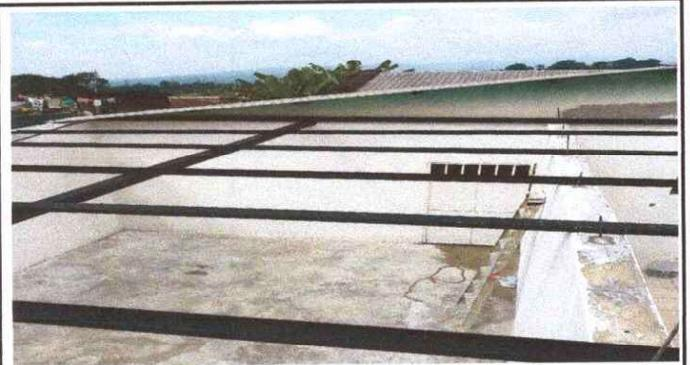
Foto 2: Sustrucción de estructura de metal por metal: Se observa que las costaneras estan muy oxidadas y muy picadas.
