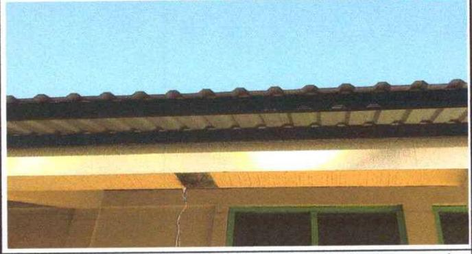
Foto 8: Mantenimiento estructura de soporte de metal: Se observa que la estructura tiene mucho óxido.
