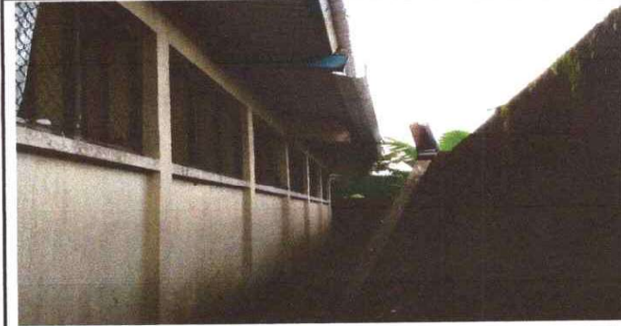
Foto 7: Sustrucción de canal de metal: Se observa que el canal esta en partes quebradas.
