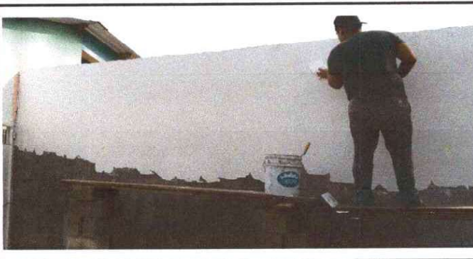
Foto 5: Cernido de muro: Se observa que falta una parte del muro que no esta cernido.
