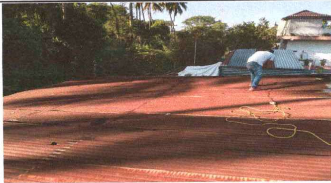
Foto 1: Sustitución de lamina troquelada calibre 26: Se observa que las laminas estan muy picadas entra demasiada agua.
