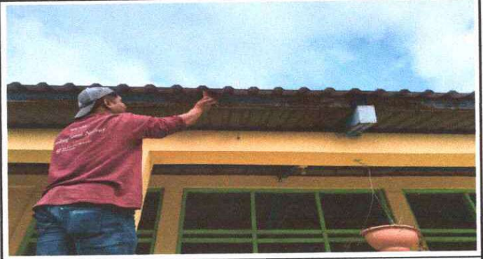
Foto 8: Mantenimiento estructura de soporte de metal: Se observa que la estructura tiene mucho oxido.
