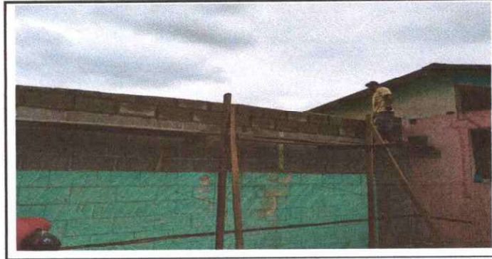
Foto 6: Sustitución de muro perimetral de block: Se puede observar que el muro tiene grietas y mucha porosidad.
