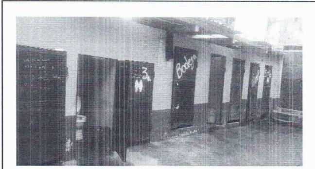
SE OBSERVA EL DETERIORO DE LAS PUERTAS POR EL AGUA Y PROVOCO CORROSION EN LAS MISMAS
