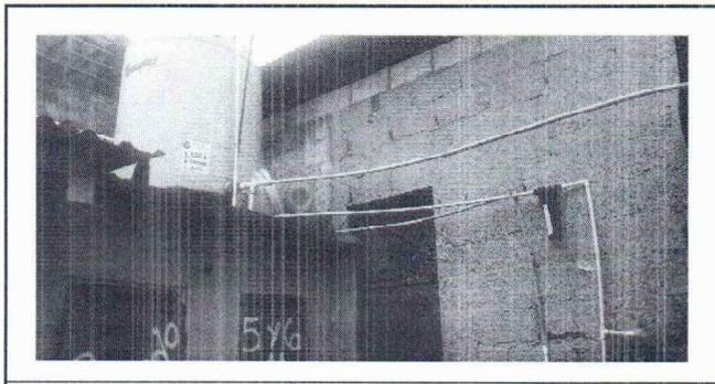
LA TUBERIA DE AGUA POTABLE NO SE ENCUENTRA EN FUNCIONAMIENTO POR EL DETERIORO DEL MATERIAL SE DEBE REALIZAR EL CAMBIO INMEDIATO
