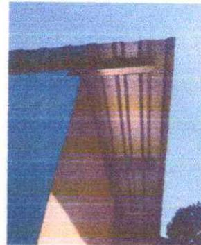
Foto 4: SUSTITUCIÓN DE LÁMINA POR LÁMINA TROQUELEADA ALUZINC CALIBRE 26 (incluye capote, toenillo, desmontaje y montaje)
